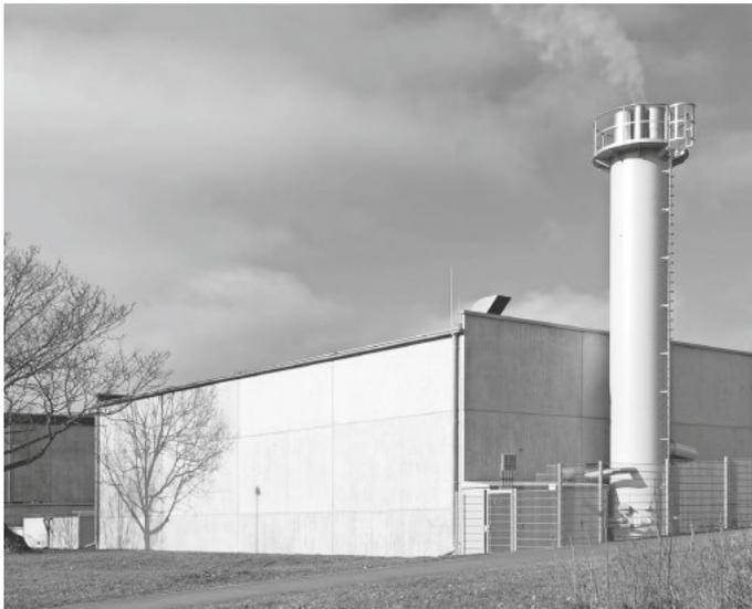
Um eine Zirkulation des Nahwärmewassers zu erzeugen, wird in der Heizzentrale Umwälzpumpen eingesetzt, die im Vorlauf einen höheren Druck erzeugen als im Rücklauf. Diese Druckdifferenz lässt das Nahwärmewasser zwischen Abnahmestelle und Heizzentrale zirkulieren. Bis heute wurden 5 km Trassenlänge verbaut.
